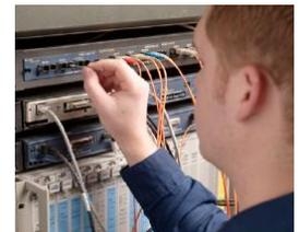
*A principal causa de falhas nas fibras são conexões sujas. O uso de limpadores projetados e dimensionados para limpeza das portas internas pode eliminar uma fonte de problemas frequentemente ignorada.*
